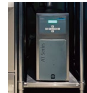
水道水に含まれるカルキなどの不純物を濾過する純水装置。
